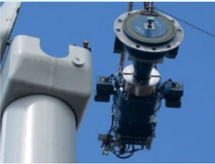
Diese riesige Baugruppe aus einem 12 t schweren Getriebe mit Scheibenbremse wird mit einem Kran auf eine Höhe von 60 m angehoben, damit sie im Maschinenhaus dieser Windkraftanlage montiert werden kann.
