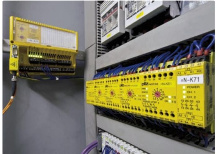
**Die kompakten Steuerungssysteme PSS 3000 für sicherheitsgerichtete und Standard-Steuerungsaufgaben lassen sich sowohl in Einzelschichten als auch in ausgedehnten Anlagen einsetzen.**
