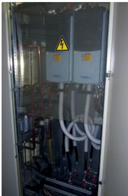
Die wassergekühlte Lösung ermöglicht deutliche Energieeinsparpotenziale in der Zuckerproduktion.
