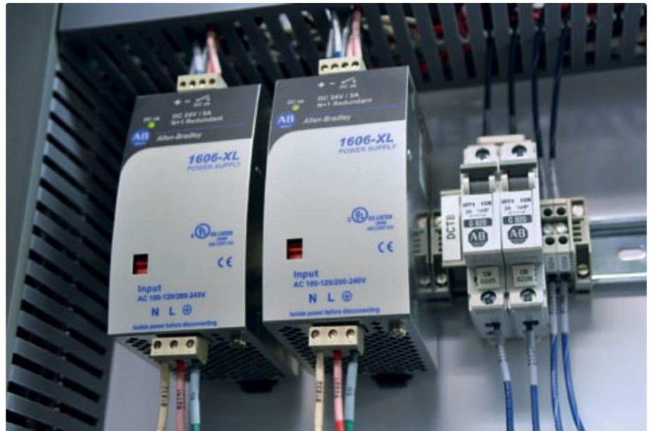
Im Einsatz: Das Schaltungskonzept der Netzteile Allen-Bradley 1606 führt zu einem Minimum an Welligkeit und Störungen und schützt vor Kurzschlüssen und Drahtbruch.
