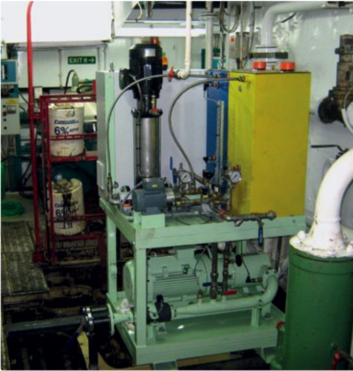
Der CD92-Mycronizer ist ein nach Lloyd's Register zertifiziertes System am Markt, mit dem sich bei Dieselmotoren und Kraftwerken der Stickoxid-Anteil in den Abgasen deutlich reduzieren lässt.
