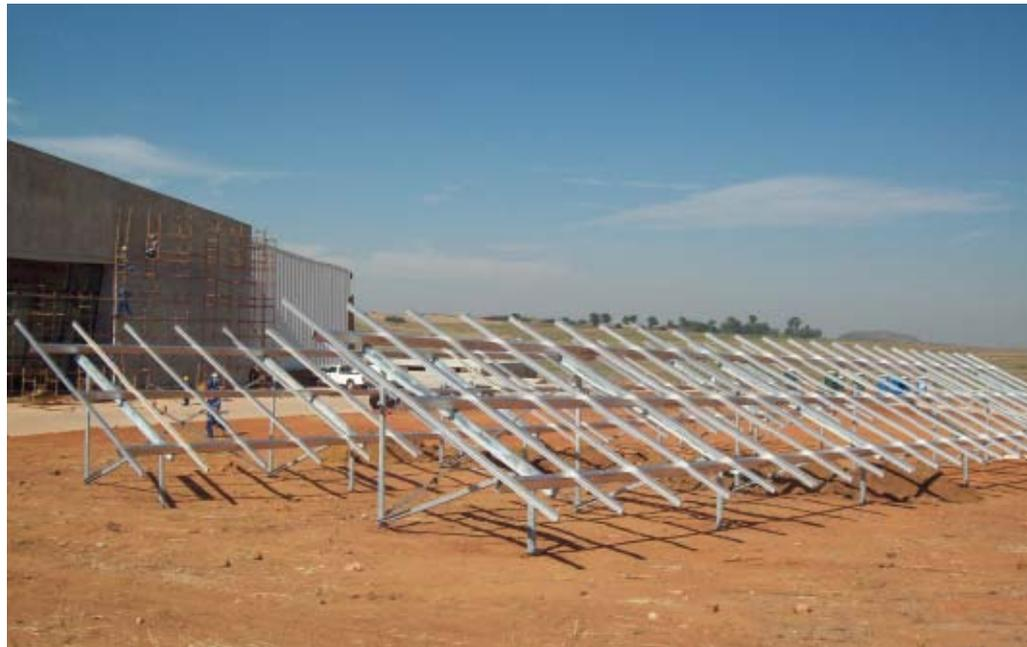
Bei der Solaranlage im südafrikanischen Heidelberg lassen sich dank des speziellen Tragegestells die Solarpanels einfach einklicken.
