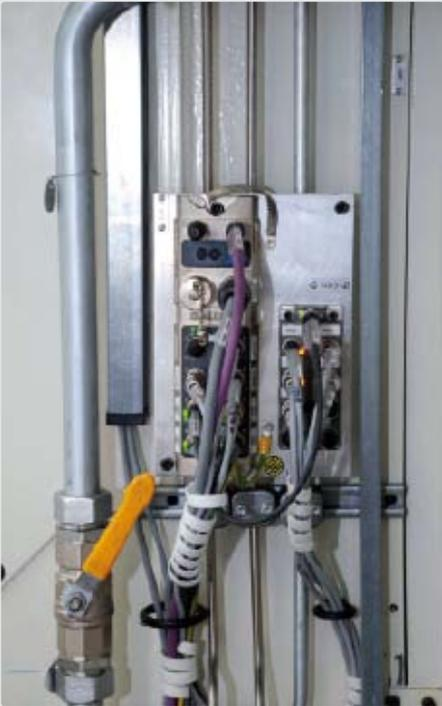
Ein Sensorhub (r.) bündelt die Signale auf einen IO-Link-Port und leitet diese dann per Dreidrahtleitung an einen Profibus-Master (l.) weiter.
