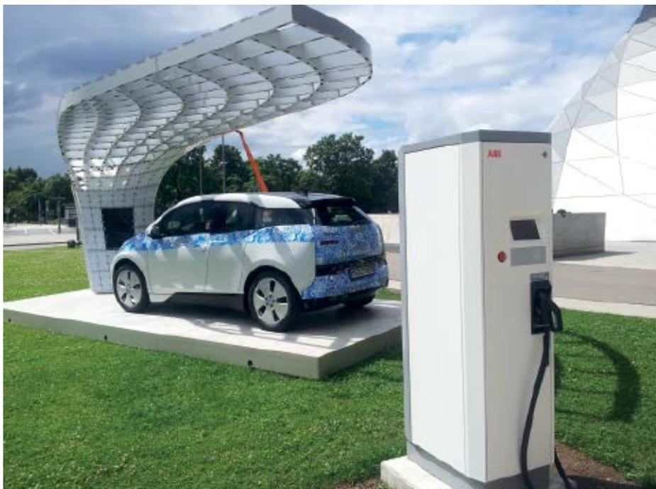
Die ABB-Ladesäulen Terra 53 mit 50 kW Ladeleistung für die Schnellaufladung von Elektroautos verwenden den CCS-Standard.
