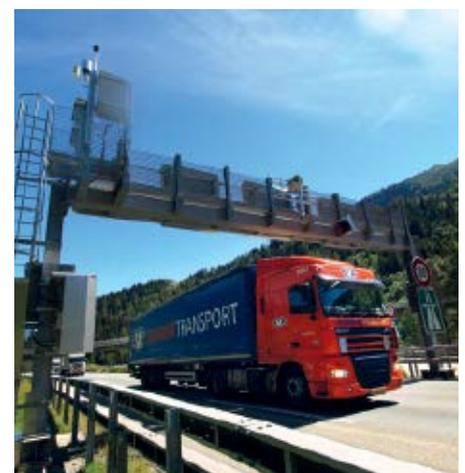
Am Karawanken-Straßentunnel ist die Thermoportal-Hardware an der Tunneleinfahrt montiert.
