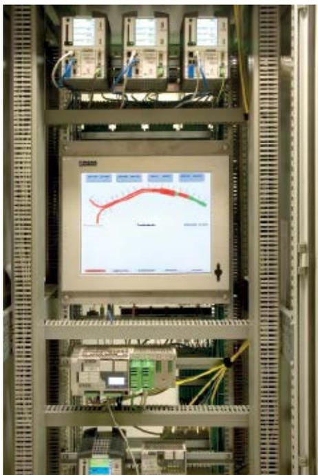
In der zentralen Steuerungseinheit sind vier RFCs verbaut, wobei das unterhalb des Industrie-PCs installierte Gerät die Entscheidung trifft, ob ein Notfall vorliegt und um welche Art von Störung es sich handelt.
