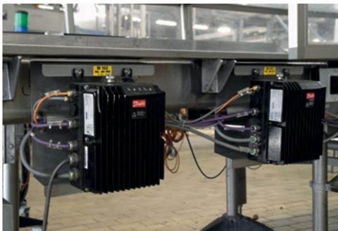
Die Datenübertragung kann über alle gängigen Feldbusse erfolgen, beispielsweise wie hier mittels Profibus DPV1. Motornaher oder motormontierter Installation der Frequenzrichter reduziert die EMV-Beeinflussung.
