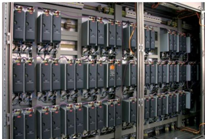
Auch in großen Anlagen lassen sich Frequenzrichter in zentralen Schalträumen einsetzen, wie hier in einer Abfülllinie, bei der die gesamten Transporterantriebe zentral im Schaltschrank zusammengefasst sind.
