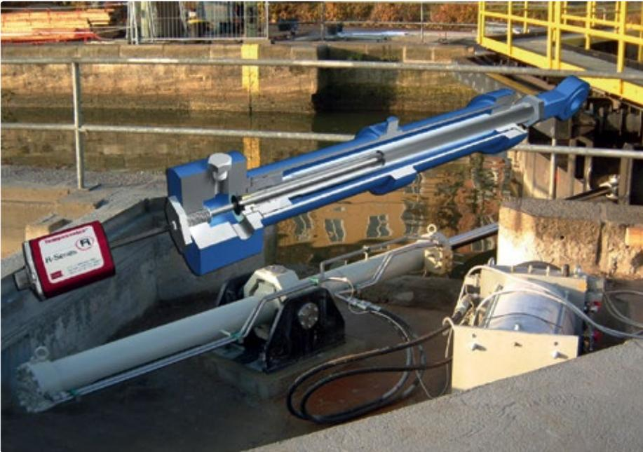
Im Stemmortantrieb der Schleuse sorgen integrierte Wegaufnehmer für einen positionsgeregelten Zylinderhub.
