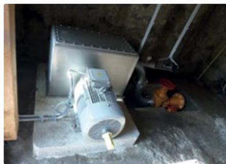
**Der Generator von Johannes Hübner Giessen stellt aufgrund seiner Überdimensionierung ein stabiles Inselnetz zur Verfügung.**
