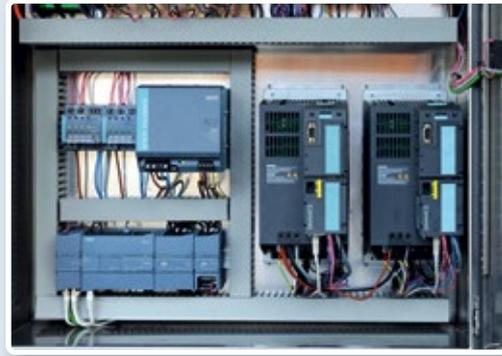
Die zentrale Steuerung der Salat-Waschanlage übernimmt eine Simatic S7-1200 CPU, zwei Umrichter (Sinamics G120) steuern den Motor des Schleuderrotors und des Tauchlifts.
