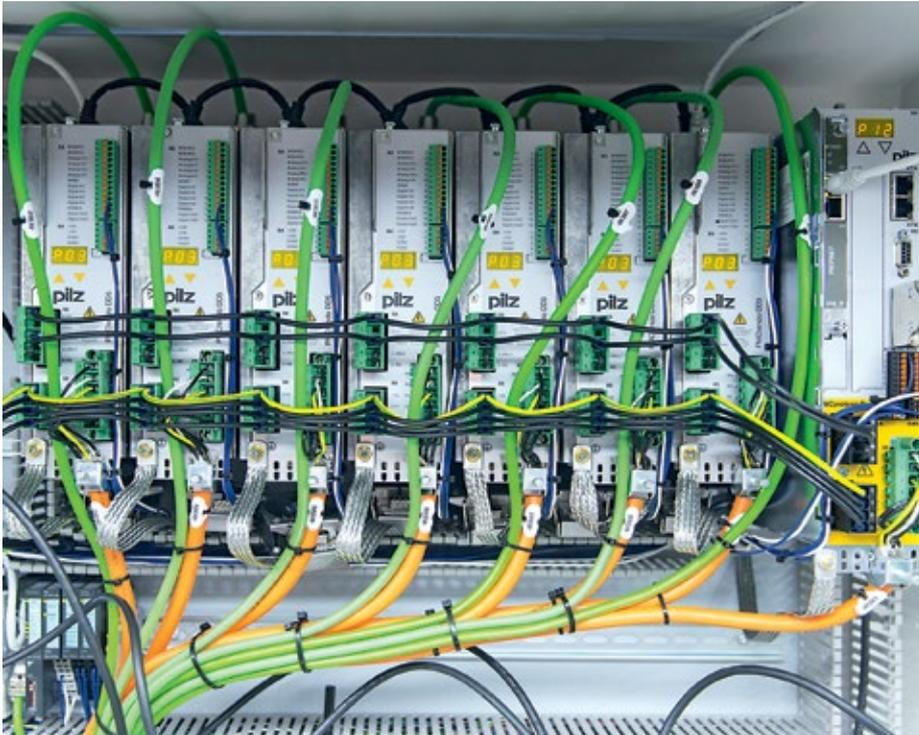
Die in der Anlage verbauten 39 Servoverstärker PMCprotego D und PMctendo DD5 mit Profinet-Anbindung von Pilz steuern die rotatorische wie auch lineare Motorik.
