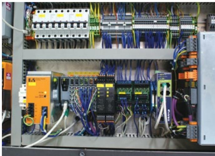
Der Fernwartungsrouter eWON wird im Schaltschrank der Treif-Maschine neben der Steuerung platziert und stellt über eine Breitbandverbindung oder auch via LTE die Verbindung zum Online-Serviceportal Talk2M-Server her.
