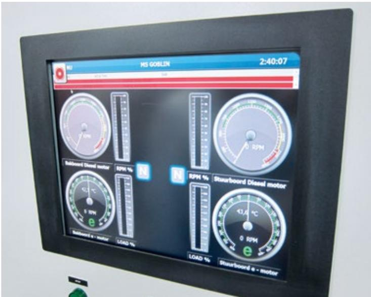
HMI des Hybridsystems mit graphischer Darstellung/Tachofunktion
