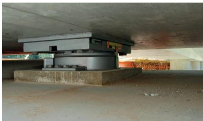
Brückenlager mit eingebautem Elastomerkissen, Fettschicht und Drucksensor
