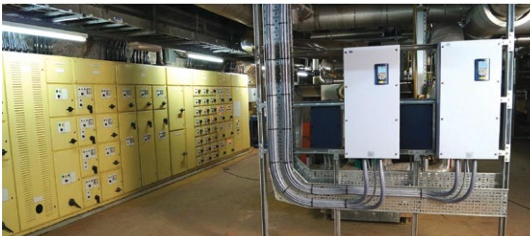
Ein Frequenzumrichter sorgt für die Steuerung der Drehzahl, wodurch der Drehstromasynchronmotor geschützt wird.
