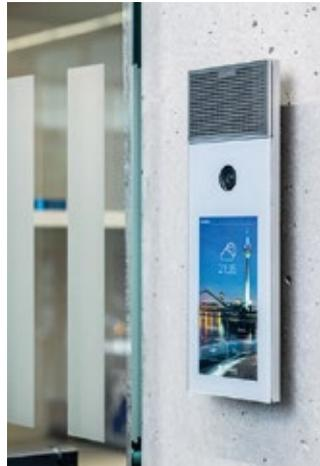
Flexibel angepasst auf die Situation: Im Bedarfsfall kann aus der Sprechstelle in Sekundenbruchteilen ein Fluchtweg-Terminal werden
