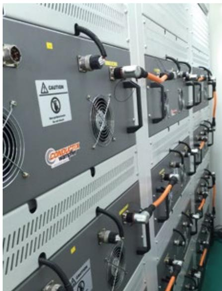
Die Batteriesysteme sind direkt am Kran installiert. Auf diese Weise kann sich der RTG-Kran völlig autark bewegen.
