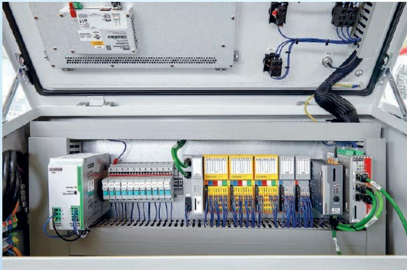
Vom Netzteil über die Steuerung mit Standard- und sicheren I/O-Modulen bis zur sicheren Fernwartung über das Mobilfunknetz enthält der Schaltkasten zahlreiche Komponenten von Phoenix Contact.
