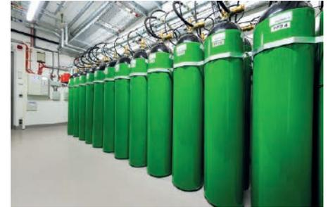
Den Nachweis, dass die zweistufige Absenkung bis zum Minimalsauerstoffwert von 13,8 Vol.-% wie geplant funktioniert, hätten Probeflutungen erbracht, berichtet Wagner-Projektleiter Marco Bachmann. Dieser Nachweis der Funktionalität kann mithilfe der verbauten Lösung jederzeit wiederholt werden.
