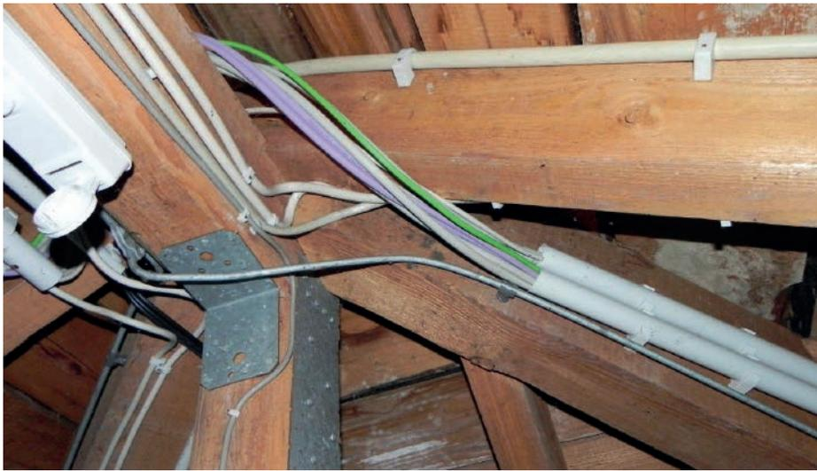
Abb. 3: Nicht eingehaltener Trennungsabstand von Leitungen zu Blitzableiter
