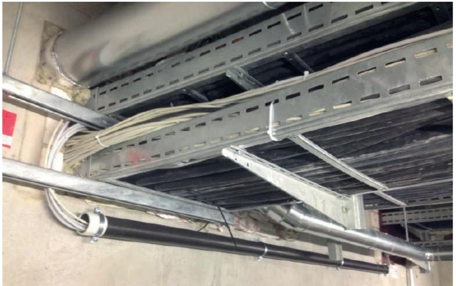
Abb. 1: U.a. nicht eingehaltene Trennungsabstände zwischen Stromversorgungsleitungen und nachrichtentechnischen Leitungen
