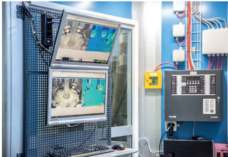
Drei Eskalationsstufen wurden programmiert: Eine Warmmeldung bei einer kritischen Temperatur, den Produktionsstopp, wenn diese Grenze überschritten wird sowie den sofortigen Start des Löschvorgangs nach dem Produktionsstopp
