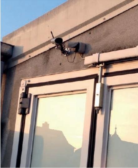
Abb. 5: Steckernetzteil einer Kamera in Schuko-Steckdose im ungeschützten Außenbereich
