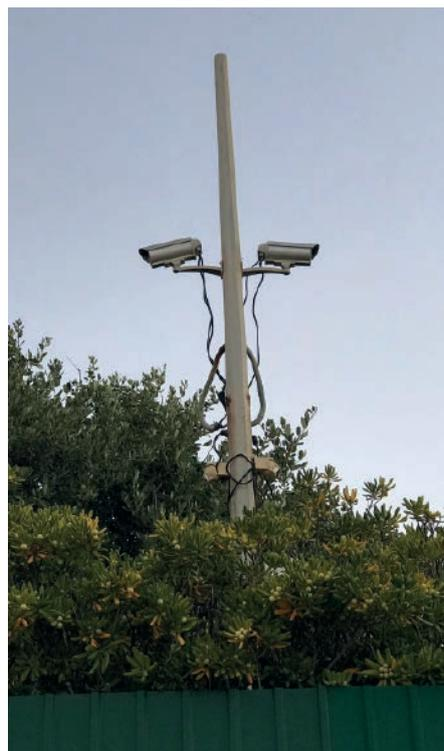
Abb. 4: Kameramast mit freifliegender Verkabelung und ohne Blitzschutz ►
