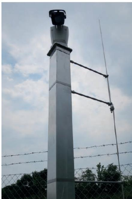
Wurden die richtigen Geräte am richtigen Ort eingesetzt, so mangelte es teilweise an der korrekten Montageweise. Häufig wurden Geräte, insbesondere Kameras mit z.B. Vandalismusschutz nicht ausreichend fest montiert (z.B. minimalste Verschraubung). Selbstredend sollte natürlich auch das Leitungsnetz entsprechend gegen Vandalismus und Sabotage (siehe Abb. 4) geschützt sein.
