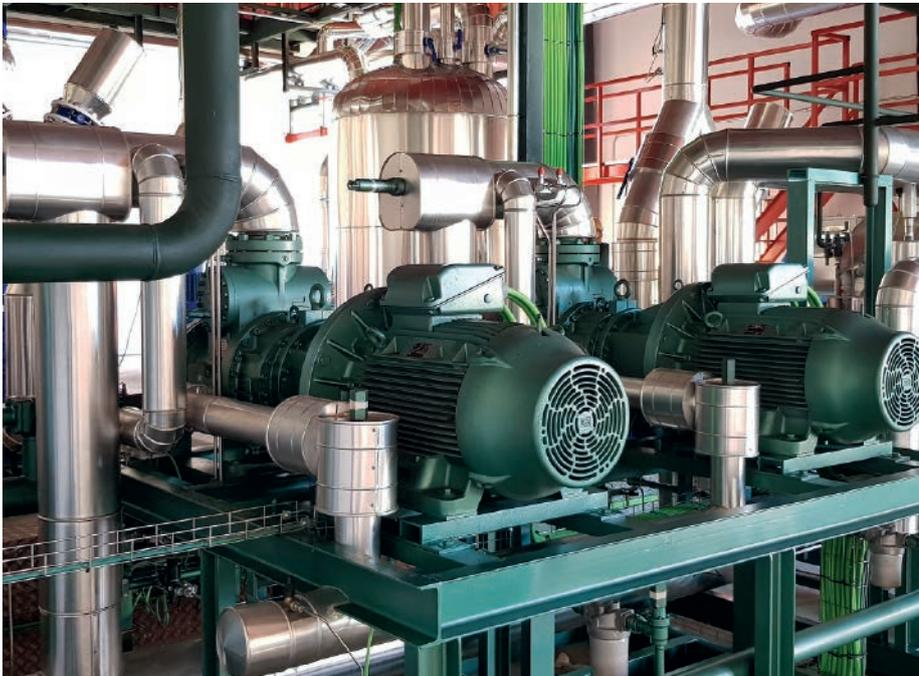
Die bei Mafresa eingesetzte Lösung mit den W22-Permanentmagnetmotoren umfasst CFW11PM-Umrichter und Synchronmotoren.
