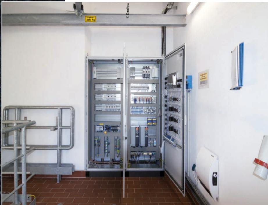
Die VLT Aqua Drives laufen häufig unter Vollast, wegen der geringen Leistung von 9,2 kW stehen Energieeinspareffekte nicht im Fokus: Dafür spart die integrierte Rückspülfunktion dem Betreiber Hamburg Wasser rund 40 Entstöreinsätze pro Jahr.
