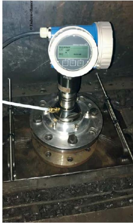
Realisierung der Messlösung mit dem Radar-Füllstandsmessgerät FMR67
