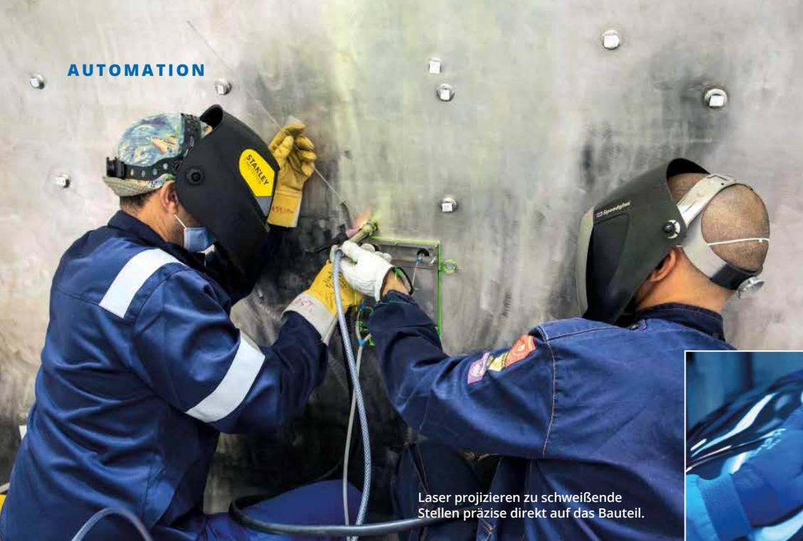
Laser projizieren zu schweißende Stellen präzise direkt auf das Bauteil.
