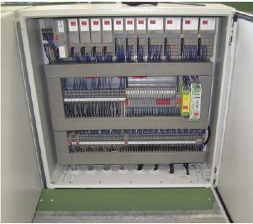
Die komplexen Fahrbewegungen sowie das sichere Abarbeiten der Abläufe bedingen eine offene und leistungsfähige SPS wie die PLCnext-Steuerung AXC F 2152.
