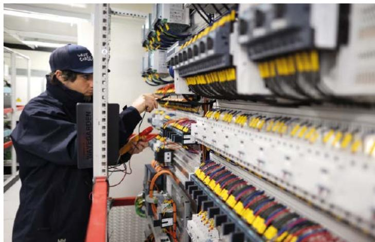
Wartungsarbeiten an den mit dem System AirStream aufgebauten Schaltschränken in einer der Installationen von Wavegarden.
