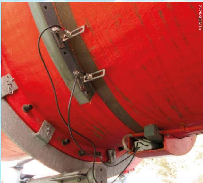
Blick unter die Abdeckung am Ende der Röhre: Hier installierte man zwei Systeme, wobei auf jeder Seite der Rutsche im Wechsel jeweils die Sender (oben) bzw. Empfänger (unten) einer Lichtschranke montiert wurden.
