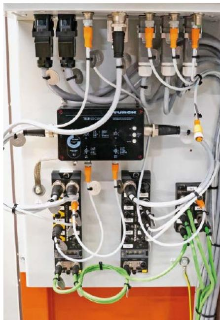
Die gesamte Sicherheitstechnik des Moduls läuft über das TBPN (unten links). Der IO-Link-Master (unten Mitte) wird durch die Safety-Box (Mitte) versorgt und kann so sicherstellen, dass alle Aktoren an den Class B Ports im Notfall abgeschaltet werden.
