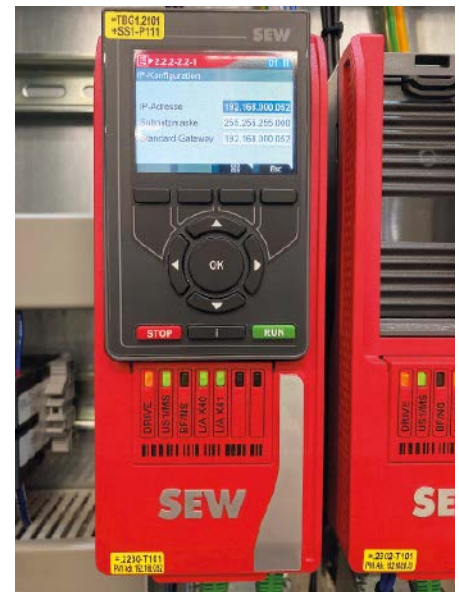
Für kürzere Inbetriebnahmezeiten wird der Frequenzumrichter Movitrac Advanced ab Werk mit spezifischen, vorkonfigurierten Setups für die Antriebseinheit Movigear Classic ausgeliefert.
