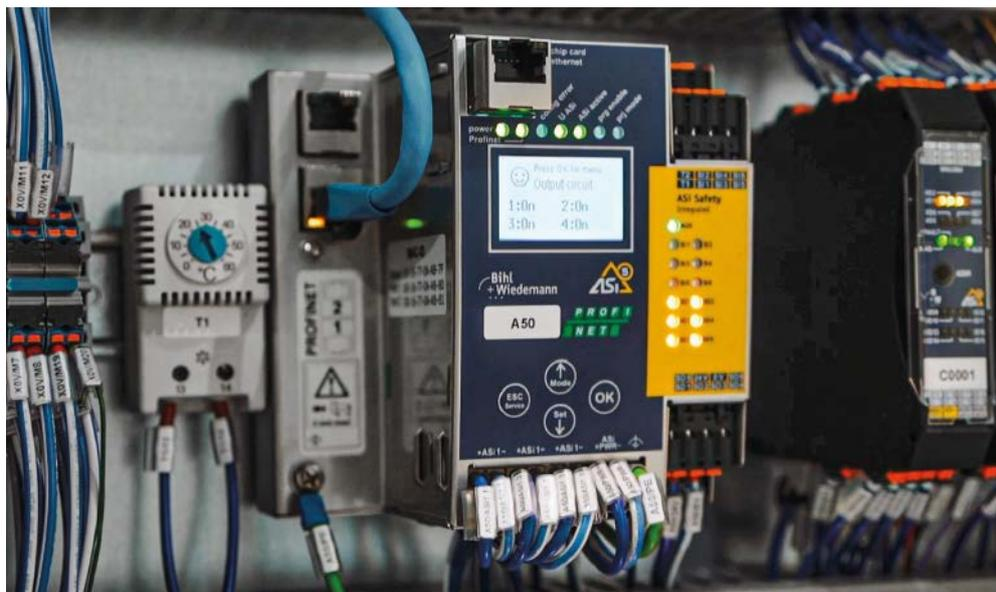
ASI-5/ASI-3-Profinet-Gateway BWU3862 mit integriertem Sicherheitsmonitor (links) und selbstkonfigurierende E/A-Module ASI-5 BWU3884 in IP20 (rechts) von Bihl+Wiedemann
