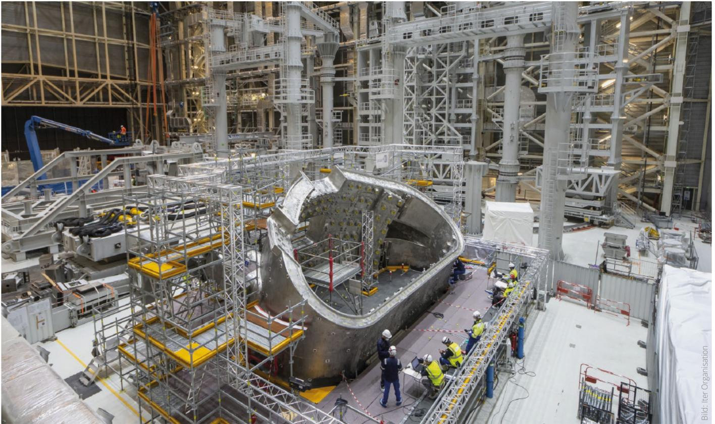
An der Außenseite der etwa 1.400 Kubikmeter großen Reaktorkammer setzen Werker 150.000 Schweißpunkte.
