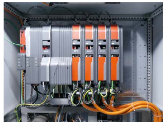
Die motornähe Steuerung, ein Filtermodul, die Netzspeisung Movidrive MDR90B und der Frequenzumrichter Movidrive modular mit vier Antriebsachsen (v. l.) sind Bestandteil des Automatisierungsbaukastens Movi-C. Die vier Heber in einer Gasse werden durch vier 32-A-Module mit je 15 kW Nennleistung angetrieben, die in einer Gruppe am Zwischenkreis zusammengefasst sind. Über diese Verbindung können sie untereinander Energie austauschen.
